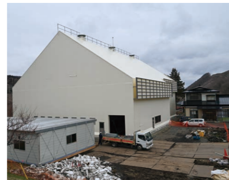
旧朴館家住宅工事現場の写真
