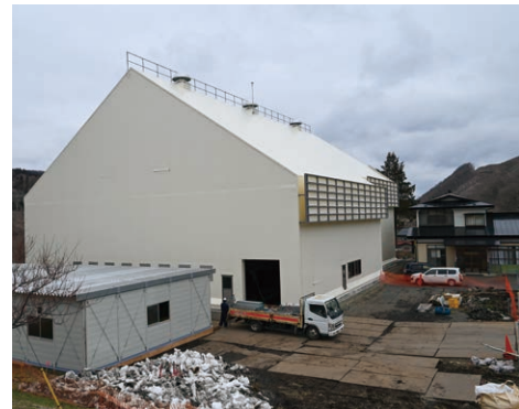
旧朴館家住宅工事現場の写真
