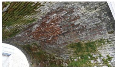
煉瓦アーチの内部
