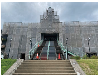
工事中のセンターハウス
