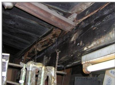
図 26：はりが破損、腐食している例
