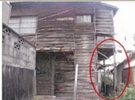
図 21：柱の数箇所に破損がある例
