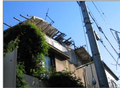
図 25：屋根が破損している例
