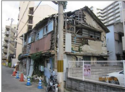
図 24：壁が脱落している例
