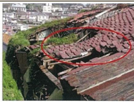
図 23：破損や変形が著しい例
