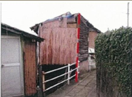
図 20：一部の柱が傾斜している例
