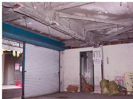
図 23：吹付け石綿の飛散の可能性が高い例
