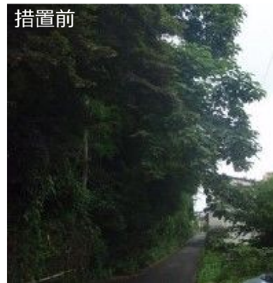
図 28：立木による通行障害の例
