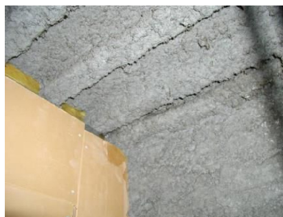
図 24：吹付け石綿の飛散の可能性が高い例
