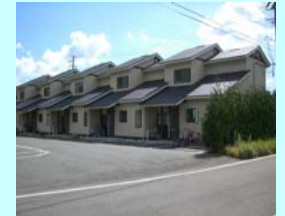
公営住宅整備事業 奥中山第1住宅(1棟5戸)
