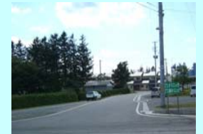
道路事業 町道奥中山第1住宅線
