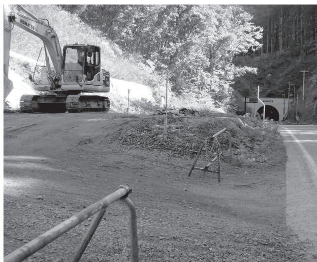
現在は工事資材置場として利用されている 町道鳥海線脇町有地
