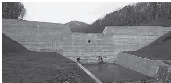
平糠沢砂防事業により整備された砂防ダム
