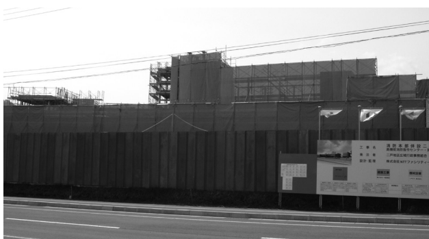
建設中の消防本部（二戸市金田一地内）
