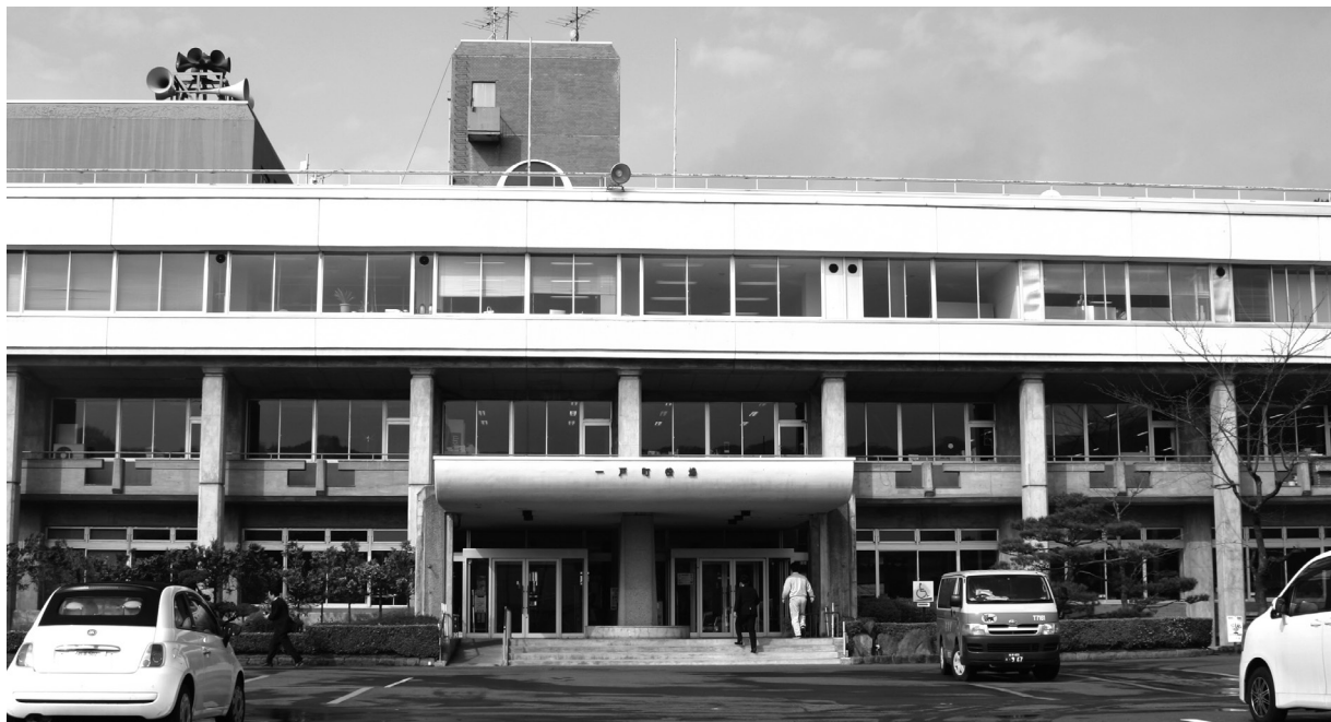
昭和 48 年に建設された役場庁舎が耐震補強と長寿命化のために改修されます
