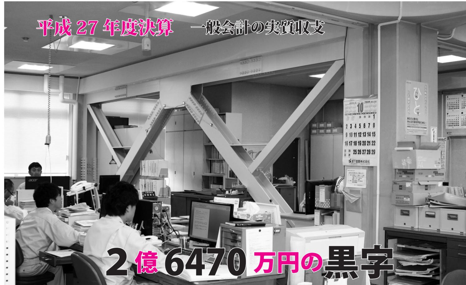
庁舎耐震工事により設置された鉄骨ブレース
