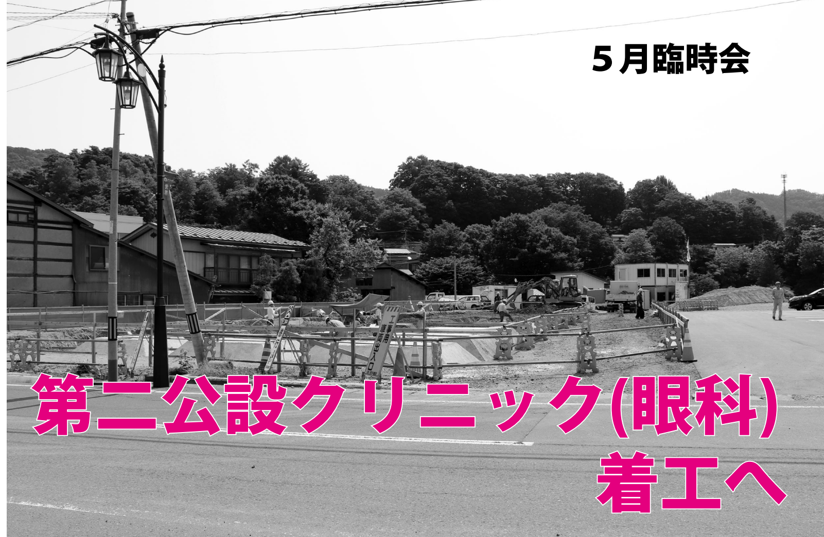
第二公設クリニック新築工事現場（一戸字向町地内）
