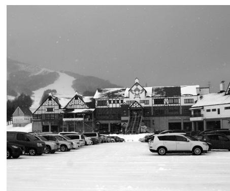
食堂などを改修するセンターハウス
