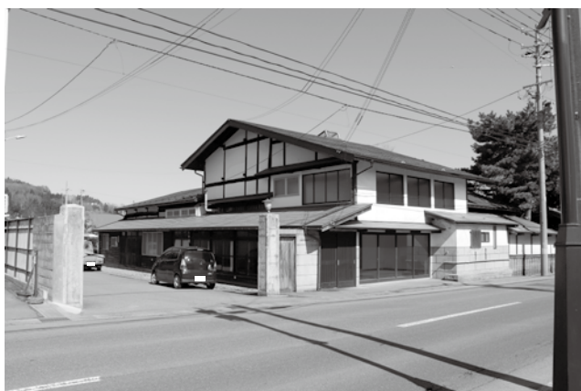
旧堀口邸の改修工事は終了しました
