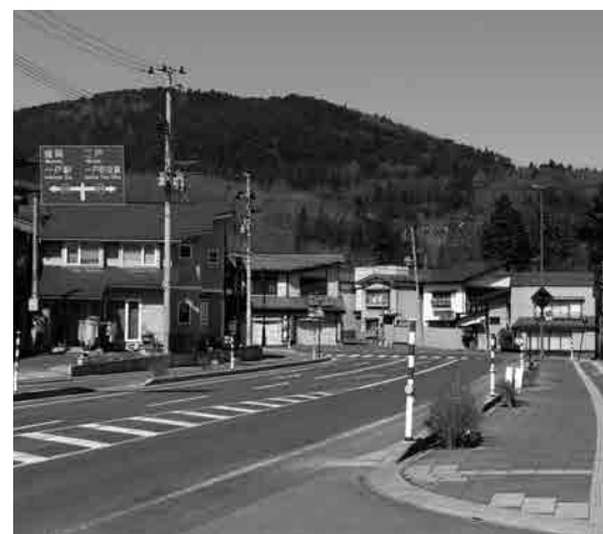
上野西法寺線（第3期）整備予定地
