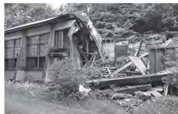
解体が待たれる旧上小友小中学校
