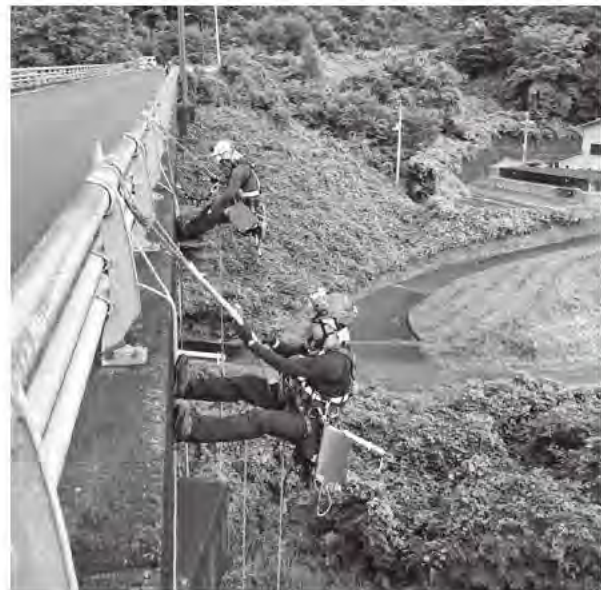
大志田橋を点検する作業員
