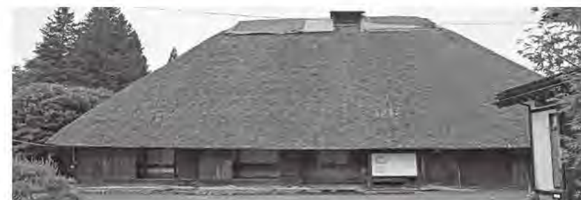
解体修理を待つ旧朴館家住宅
