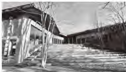
修繕が予定されるウッドテラス
