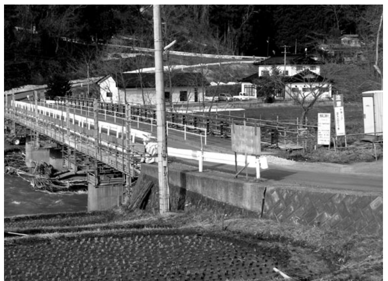
橋梁改修工事が進む八木沢橋
