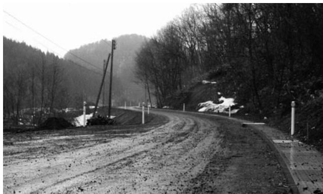
平成 23 年度より改良工事が行われている町道女鹿線
