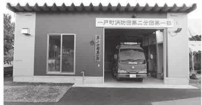
繰越明許費による事業（屯所新築工事）
