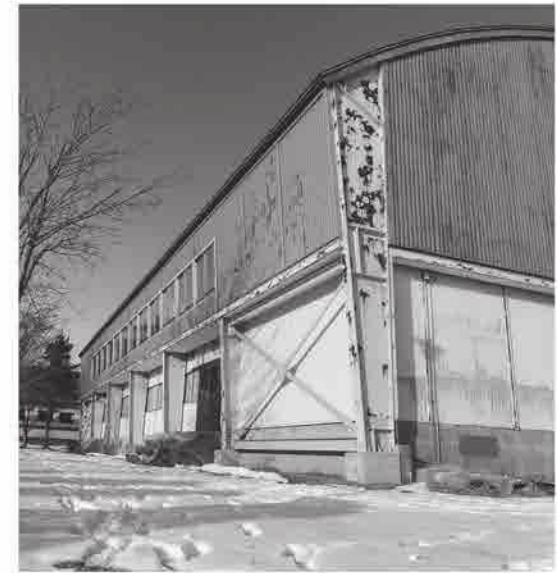
本年度補修工事を終えた奥中屋内運動場
