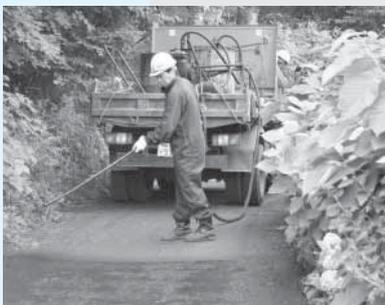
敷き詰め、重機で固めたアスファルト切削材を接着する乳剤を上からまんべんなく塗布します
