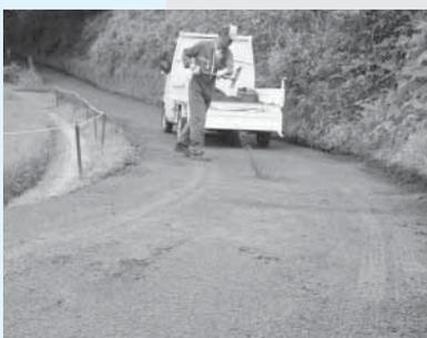
乳剤をまいた上に、スコップを使い手作業で砂をまきます。この後、再びローラーを使用し何度も締め固めて完成です
