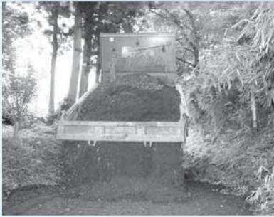
道路に砂利を敷くなどして整地してから、アスファルト切削材を道路に敷き詰めます
