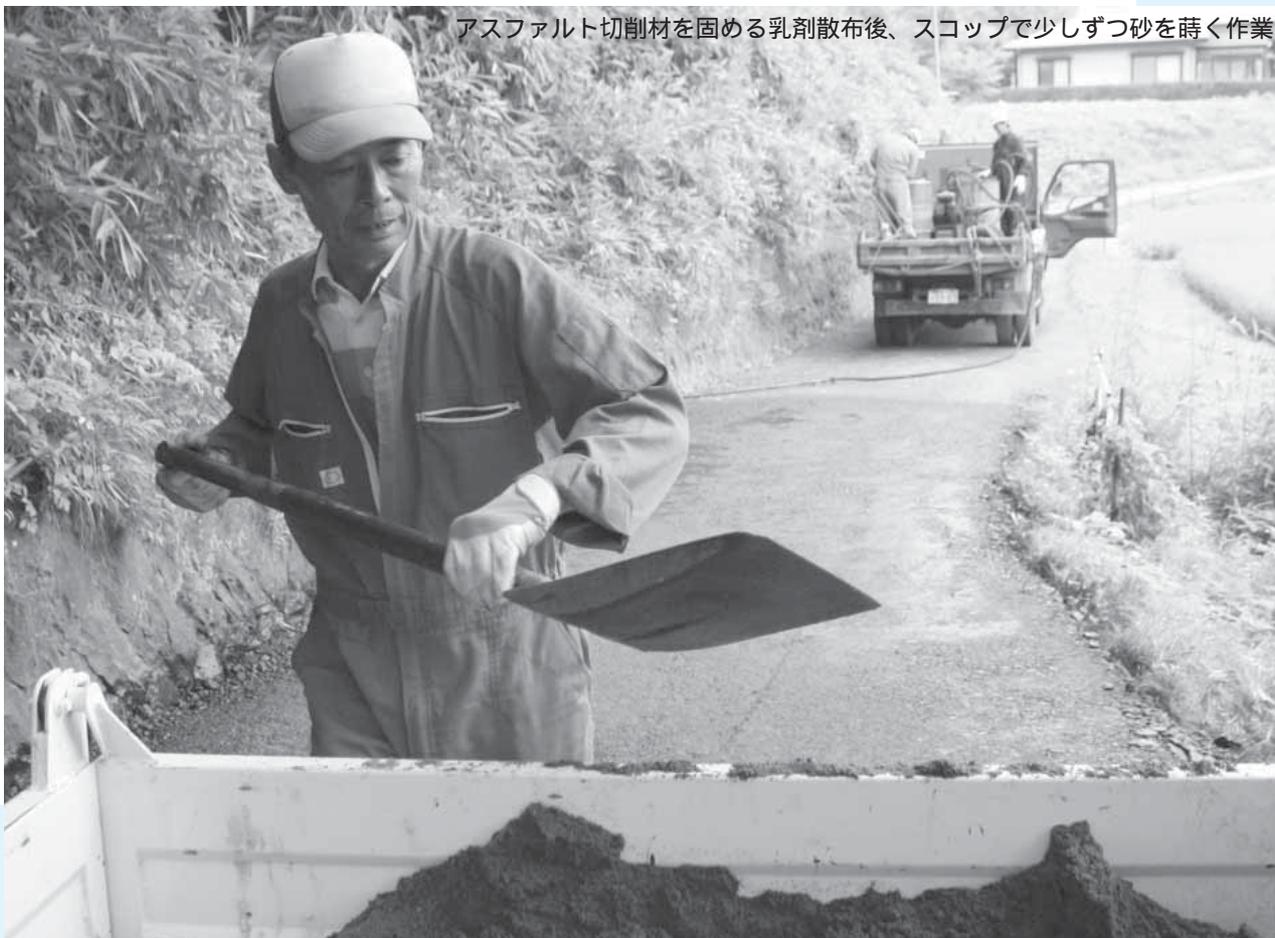
アスファルト切削材を固める乳剤散布後、スコップで少しずつ砂を蒔く作業
