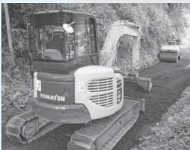
バックホーを使用してアスファルト切削材を整地し、ローラーで何度も往復して締め固めます
