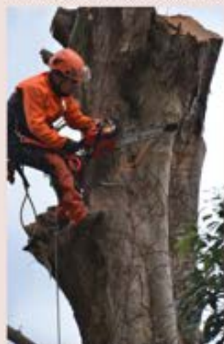
▲高所伐採・剪定による樹木環境整備（障害木除去、樹勢回復）をしました。
